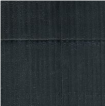
Beton in geriffelter Optik ausgeführt Storm
